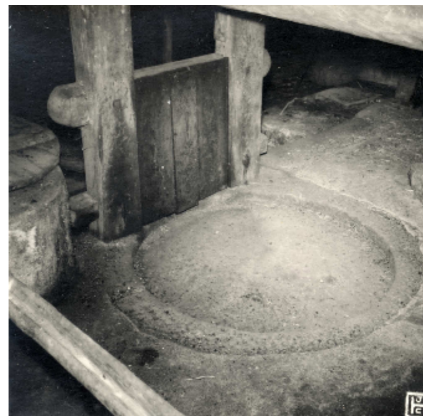
Figura 99: Aspecto do alguerbe ou sertã onde são empilhadas as seiras para prensagem (Ponte da Mata, conc. Penacova, dist. Coimbra).
