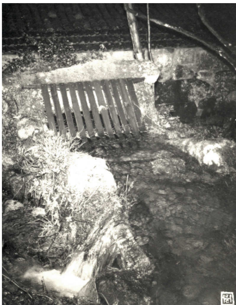
Figura 38: Cubo para entrada da água que faz accionar o rodízio , em Chacim, P. 29, freg. de Refojos, Cabeceiras de Basto, Braga.
