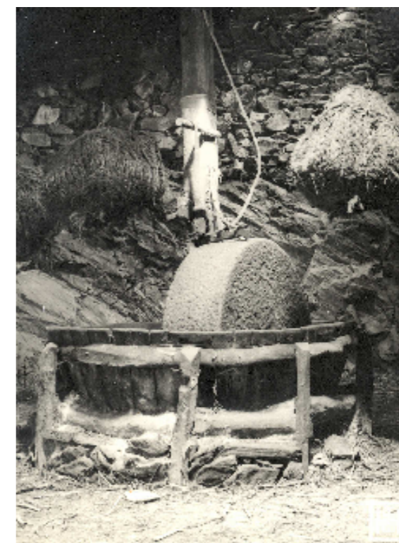
Figura 46: Aspecto do moinho do lagar de Canelas de Baixo, P. 118, freg. de Canelas, conc. Arouca, dist. Aveiro.
