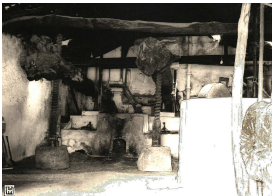
Figura 155: Aspecto geral do lagar de Pereiro, P. 262. À direita, o moinho; em segundo plano, os fusos das prensas; a seguir, a fornalha, tendo de cada lado uma tarefa; ao fundo, encostada ao canto da parede, a zona de descanso dos empregados.
