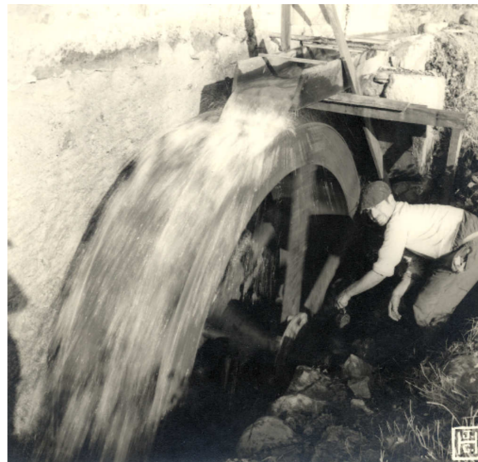
Figura 23: Aspecto da roda da água em pleno trabalho. Um moço do lagar lubrifica o veio de ferro com uma almotolia de folha de flandres. (Mata, P. 297, Vila Nova do Ceira, Góis, dist. Coimbra).
