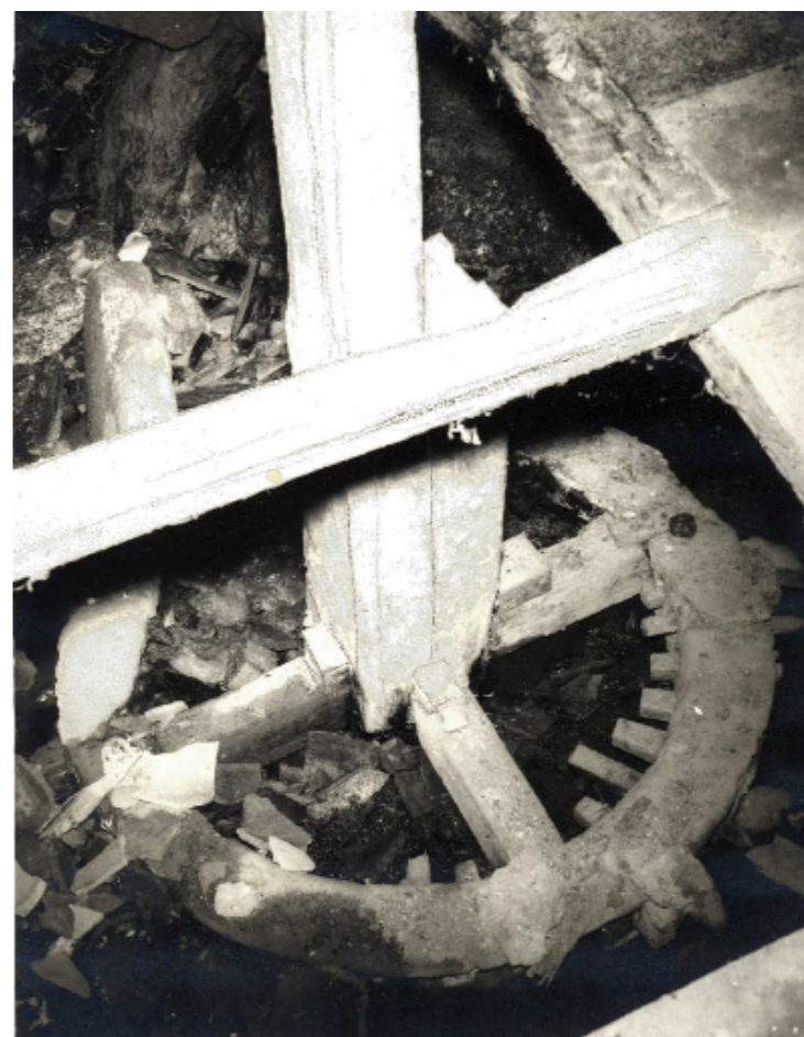
Figura 35: O que resta do rodízio do antigo lagar das Olas, P. 213, em Celorico da Beira, dist. da Guarda.
