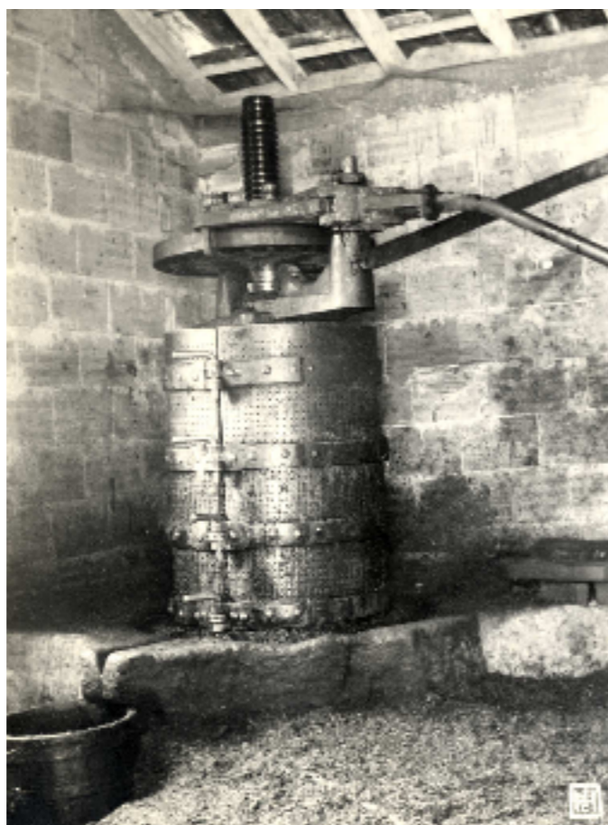
Figura 87: Aspecto de uma prensa de cincho (Sequeiros, P. 52, freg. Ancede, conc. Baião, dist. Porto).
