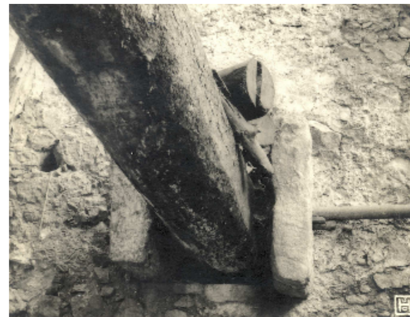
Figura 78: Agulheiras das varas. À direita, a agulha de ferro. (Vilarinho, P. 258, freg. Eiras, conc. e dist. Coimbra).
