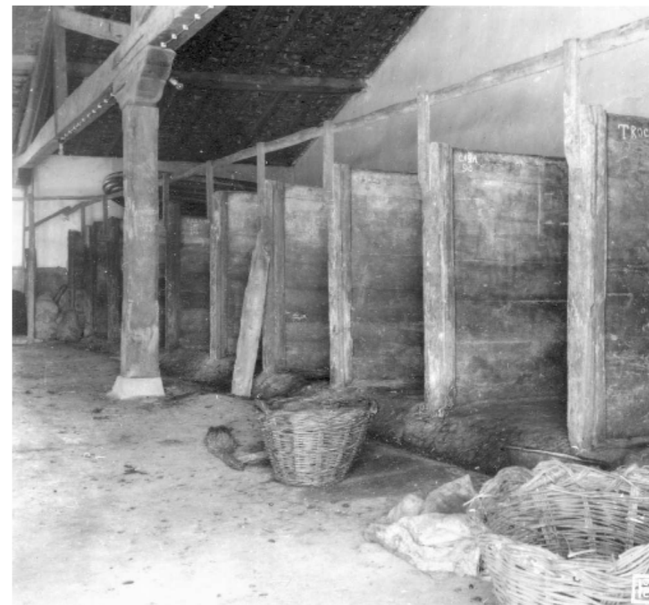
Figura 13: Aspecto das tulhas do lagar da Quinta da Portela, P. 285b, em Coimbra. No chão, os chamados poceiros para transporte e conservação da azeitona.
