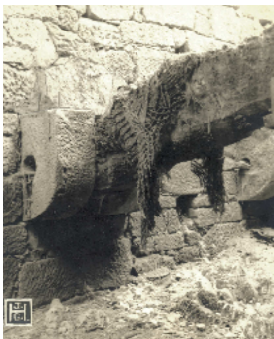
Figura 77: Sacos das varas, entre as quais ela encaixa na parede (Santo António, freg. S. Pedro, conc. Celorico da Beira, dist. Guarda).
