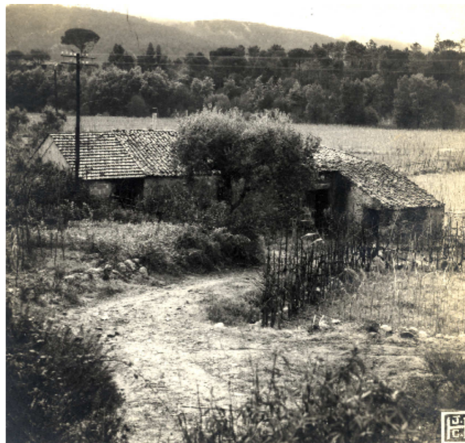
Figura 5: Lagar de vara da Mata, P. 297, Vila Nova do Ceira, conc. Góis, dist. Coimbra. Repare-se no péssimo acesso, cobertura em telha portuguesa e diminuto número de janelas.
