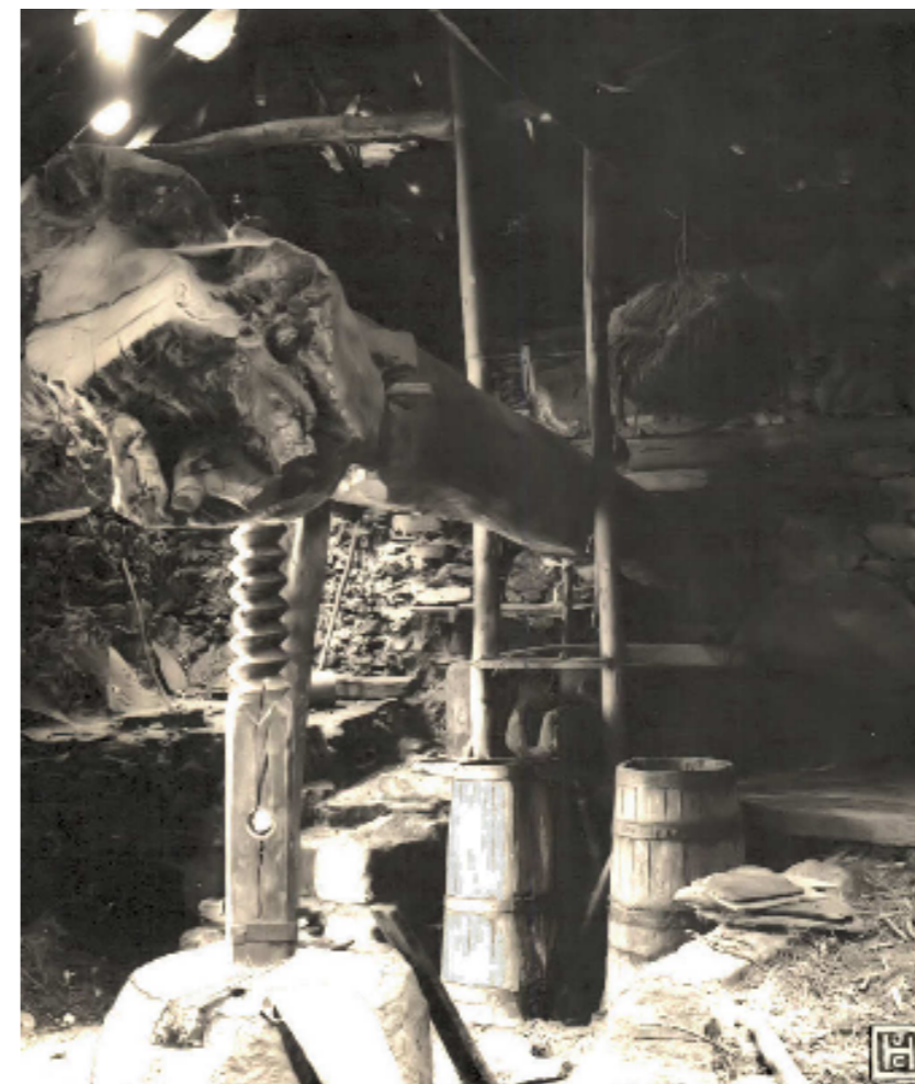
Figura 140: Aspecto da prensa de vara e sistema de decantação do lagar de Canelas de Baixo, P. 118. Em 1º plano, o fuso da vara; a seguir, os potes ; atrás, a sertã , cujo bico está preso entre os balaústes da prensa.
