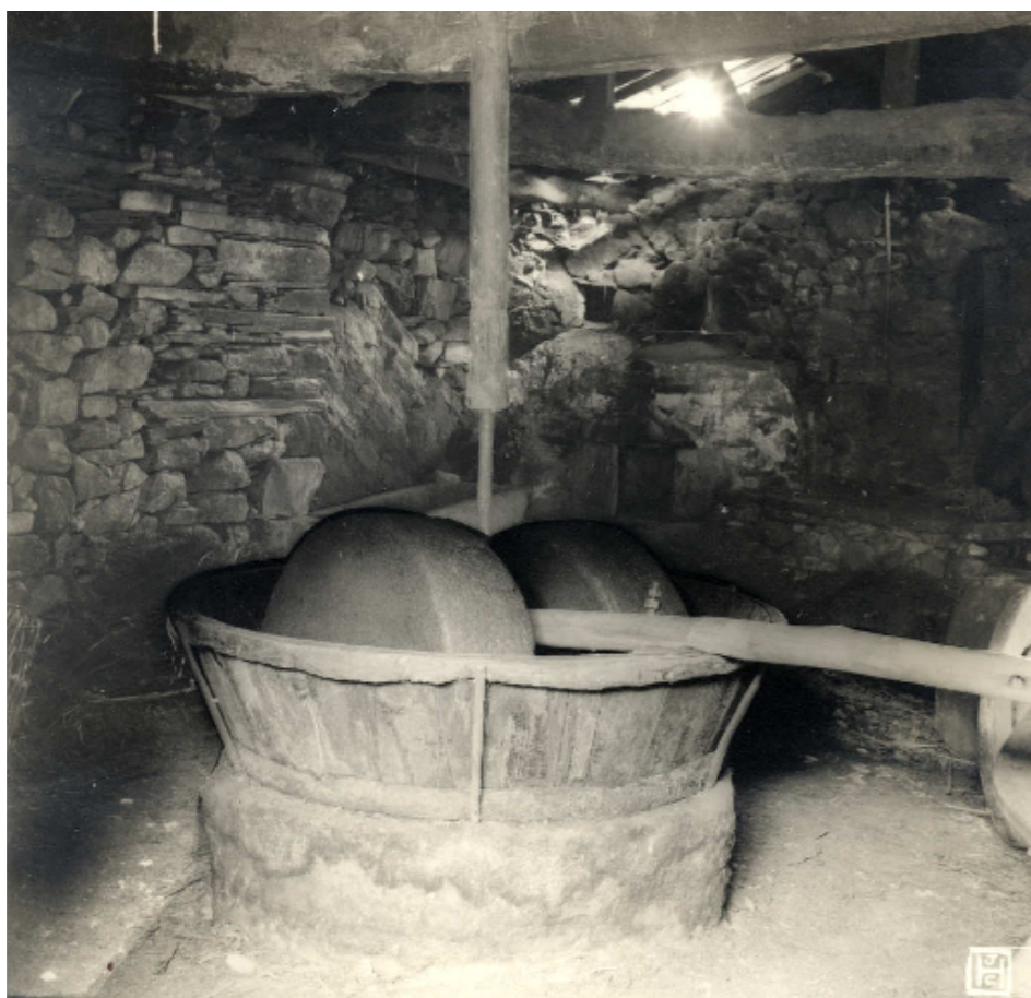
Figura 45: Aspecto do moinho de aduelas de Canelas de Cima, P. 118a, conc. de Arouca, dist. de Aveiro.
