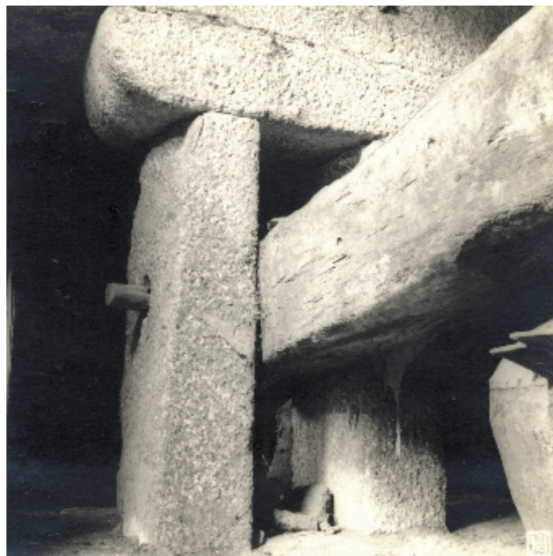
Figura 79: Pormenor das pedras que seguram a vara do lagar (Ponte do Feixe, P. 34, freg. Infesta, conc. Celorico de Basto, dist. Braga).
