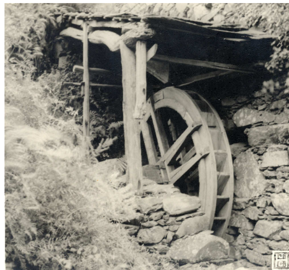
Figura 20: Roda da água feita de madeira (Ameoso do Senhor, P. 300, Alvares, Góis, dist. de Coimbra).
