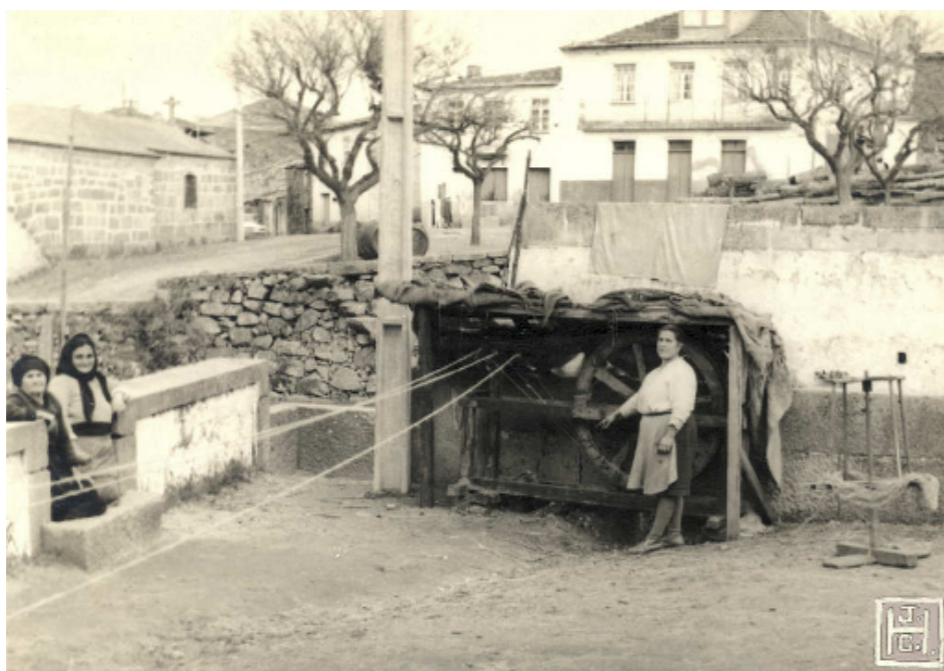
Figura 70: Aspecto do fabrico da corda. À direita, o argadilho.
