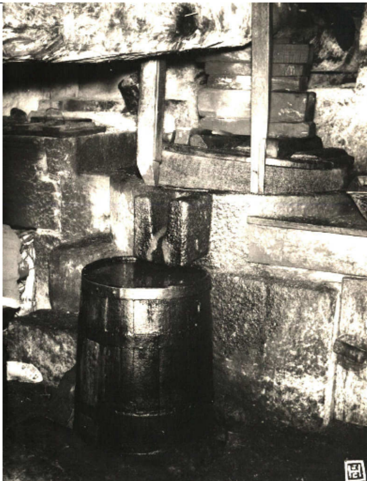
Figura 143: Sertã e pote de decantação do lagar de Cadeado, freg. Santa Marinha do Zêzere, P. 54, conc. Baião, dist. Porto, no momento da prensagem. À esquerda, a caldeira.
