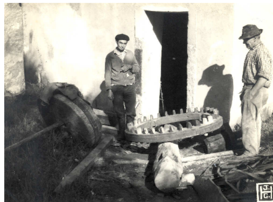
Figura 27: Reparação de uma entrosga de moinho de trigo, idêntica à dos lagares (Souselas, P. 262, conc. e dist. de Coimbra).
