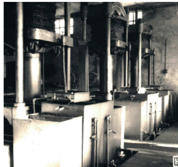
Figura 145: Tarefas metálicas do lagar de Santa Luzia, P. 138, freg. Barcouço, conc. Mealhada, dist. Aveiro.
