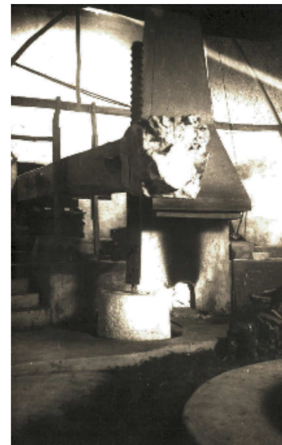
Figura 151: Aspecto da vara e fornalha do lagar das Carvalhosas, P. 286, freg. Torres do Mondego, conc. e dist. Coimbra (negativo cedido por Carlos A. Barbas).
