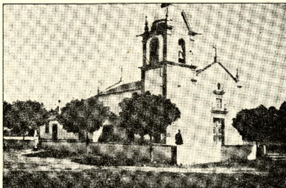
Aspecto exterior da Igreja actual
